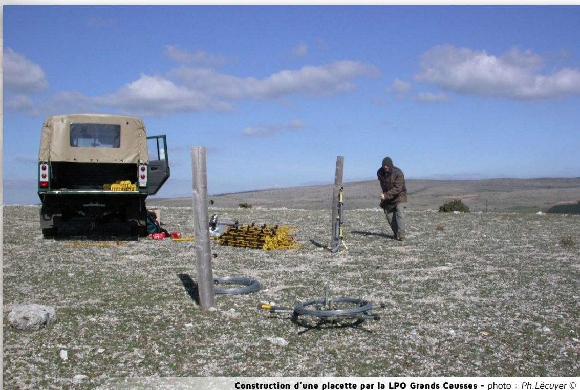
Construction d'une placette par la LPO Grands Causses - photo : Ph.Lécuyer ©
