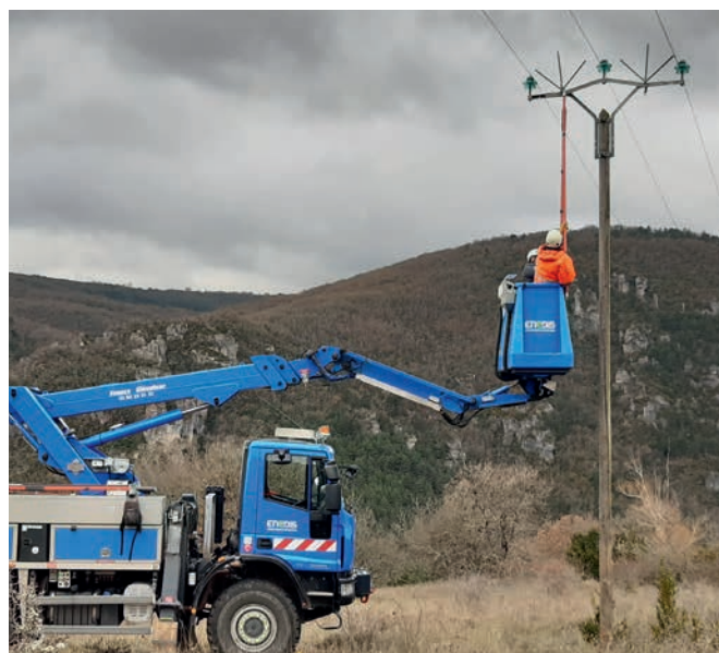
Sécurisation de lignes électriques © Laurence Galabrun ENEDIS
