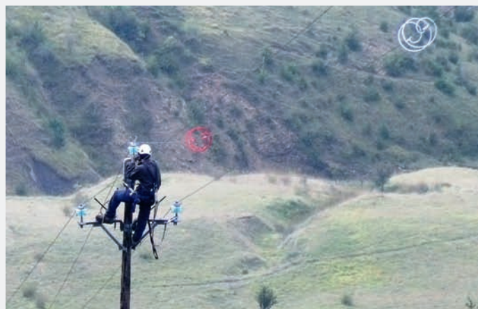
Pose d'équipements © LPO Grands-Causse
