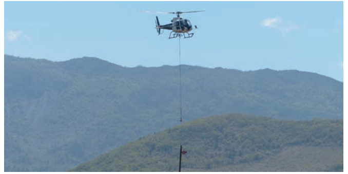
Travaux de neutralisation © Julien Traversier
