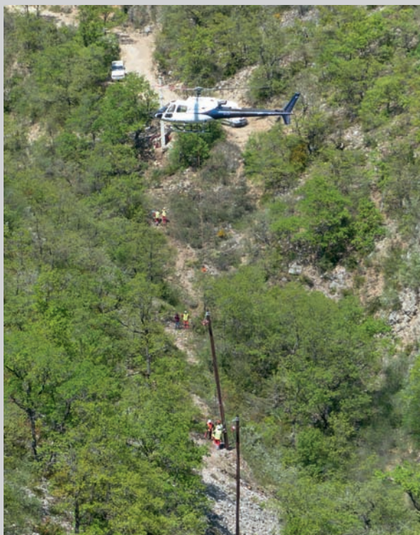
Travaux d'héliportage © VEB
