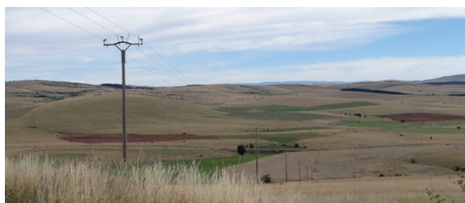
Tronçon électrique © S. Jude
