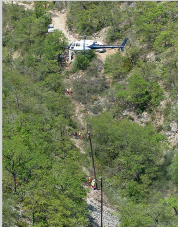
Travaux d'héliportage © VEB
